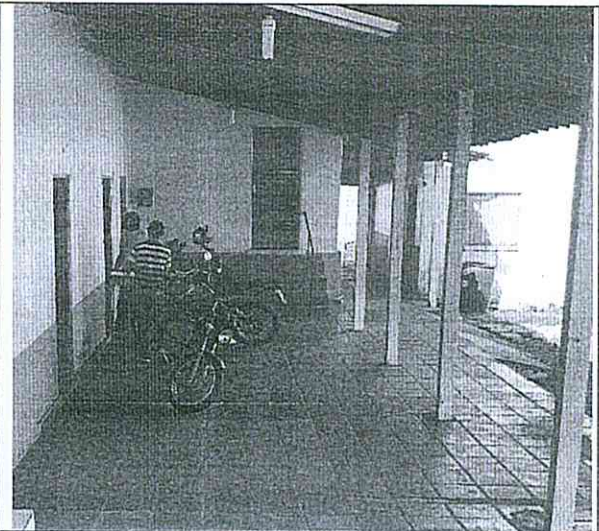
Corredor de Circulação
