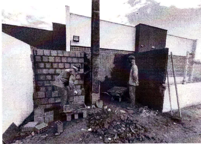
Com obras em fase de finalização, espaço será inaugurado este mês
