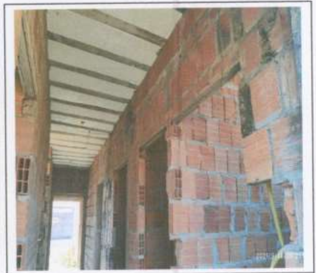
Vigas com deslocamento do concreto.
