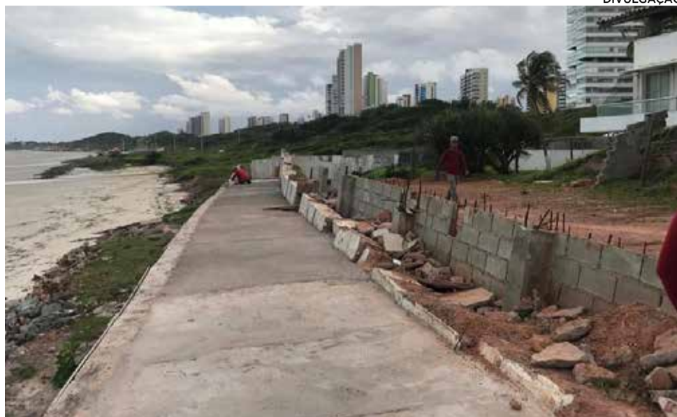
Obra está em fase de construção de muretas, muro de contenção e nivelamento de piso
