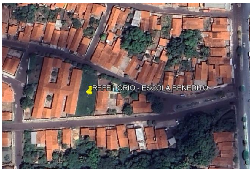
Figura 1: Local de Construção do Refeitório
