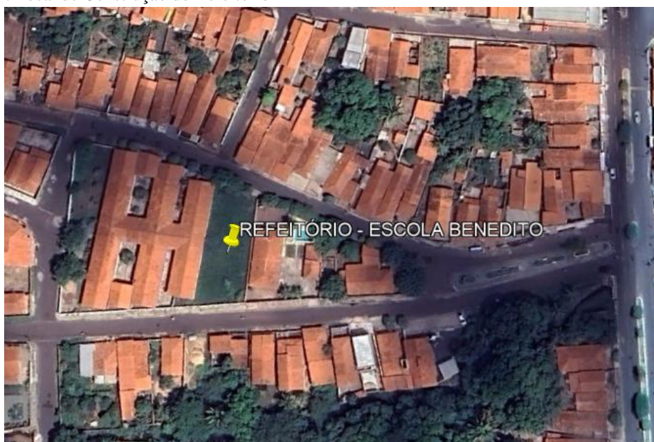
Figura 1: Local de Construção do Refeitório
