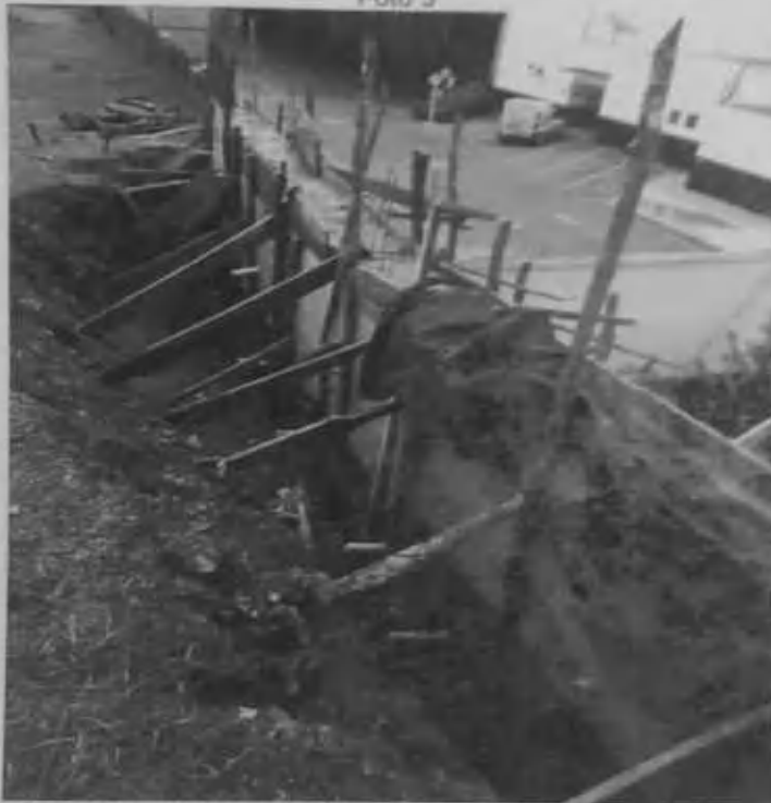
Foto da montagem das formas e concretagem da estrutura Foto fornecida por Gevaldo de Moura da Silva
